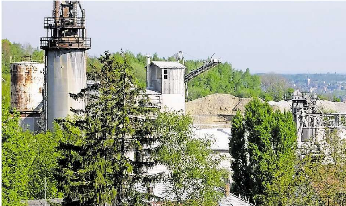
Die Gewinnung und Verarbeitung von Kalk hatte in den vergangenen Jahrhunderten eine große Bedeutung für die Stadt Eschweiler.
